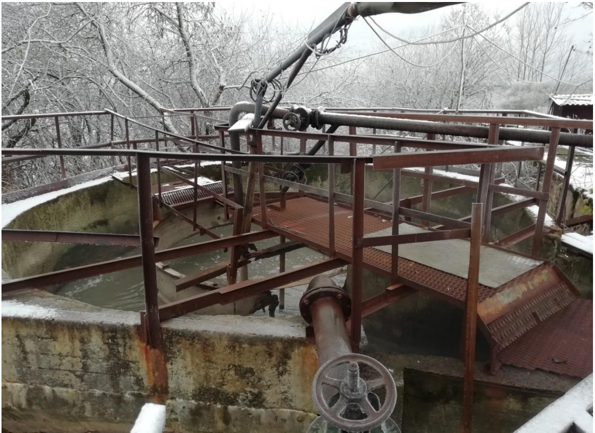
Рисунок 10. Песколовка.
