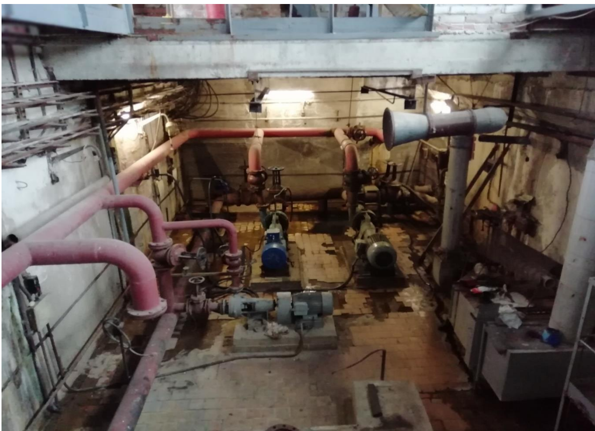
Рисунок 24. Насосная группа иловой насосной станции.
