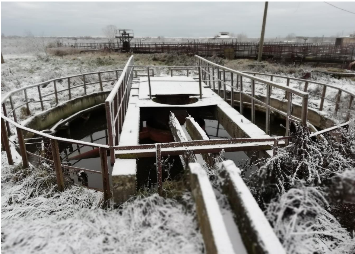
Рисунок 13. Первичный вертикальный отстойник.
