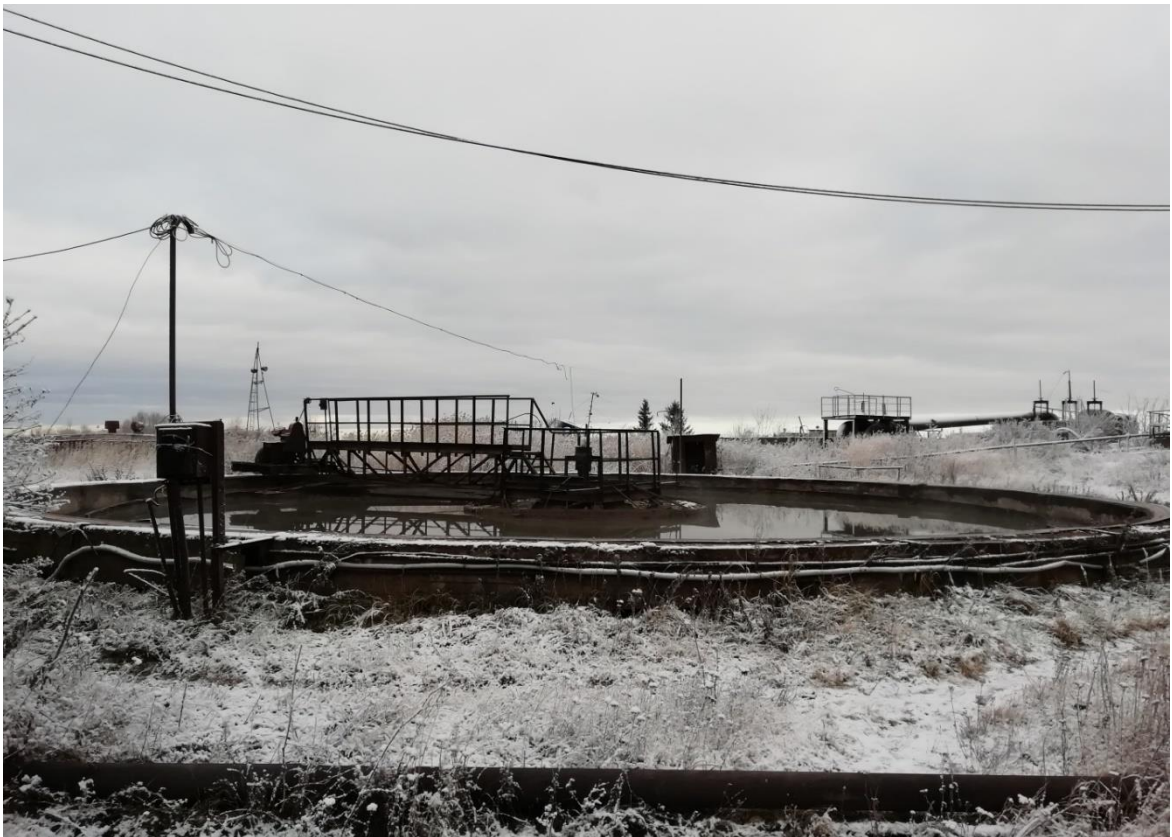
Рисунок 11. Первичный радиальный отстойник.
