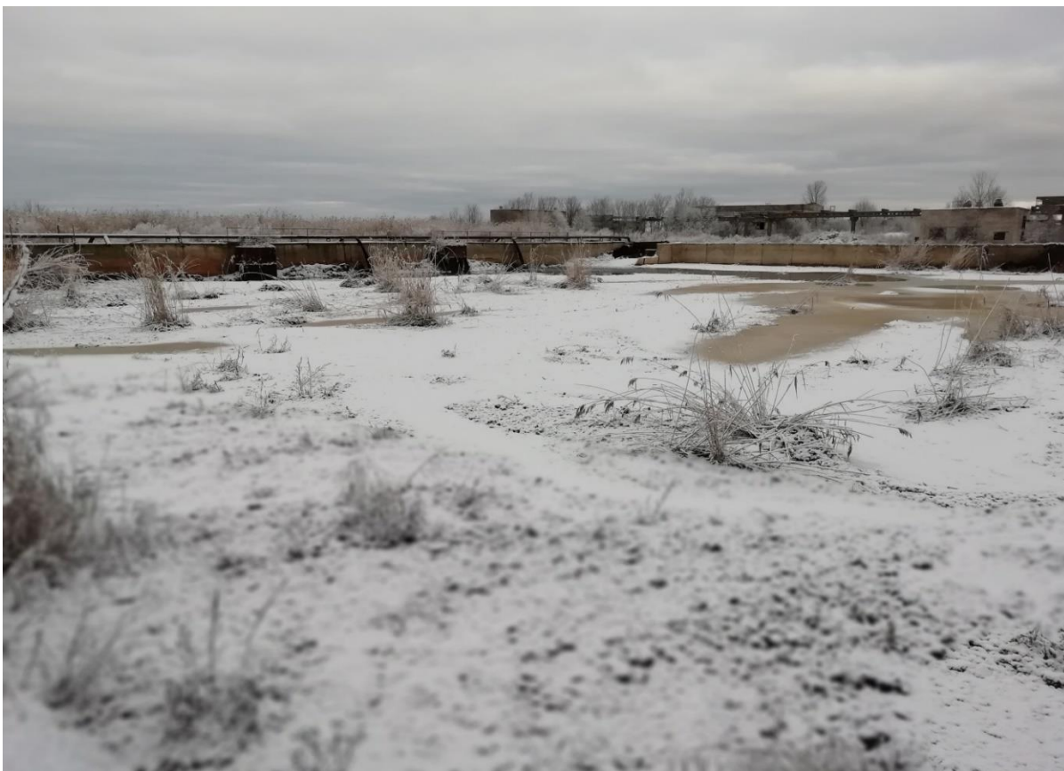
Рисунок 19. Бетонные иловые площадки.
