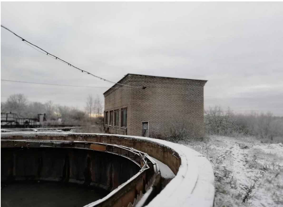
Рисунок 12. Здание иловой насосной станции.
