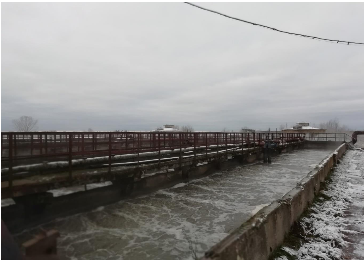
Рисунок 14. Аэротенк.
