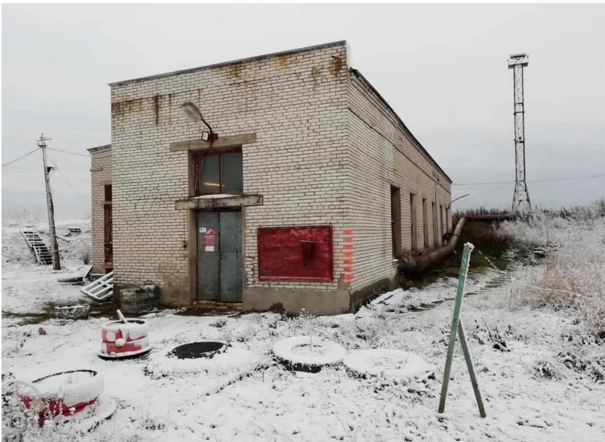
Рисунок 21. Здание насосно-воздуходувной станции.
